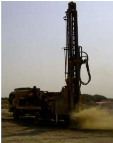
Imagen 18. Hincado de perfiles con maquinaria especializada
