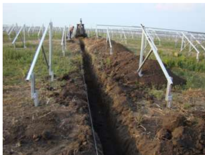
Imagen 21. Tendido de cable en zanja
