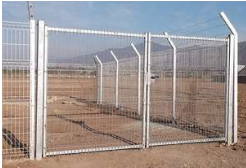
Imagen 16. Detalle de portón de dos hojas batientes tipo Acmafor
