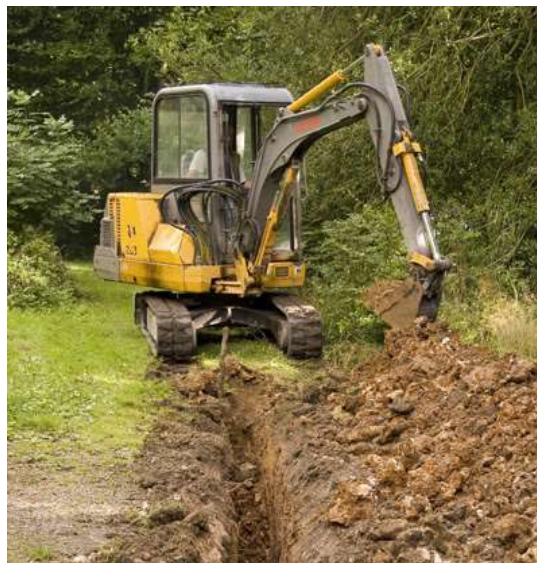
Imagen 19. Excavación de zanjas
