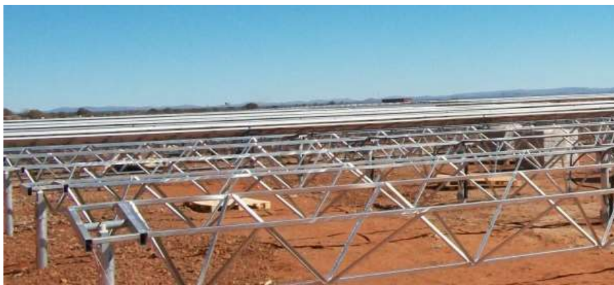
Imagen 20. Montaje de estructura solar con perfiles hincados directamente en el terreno
